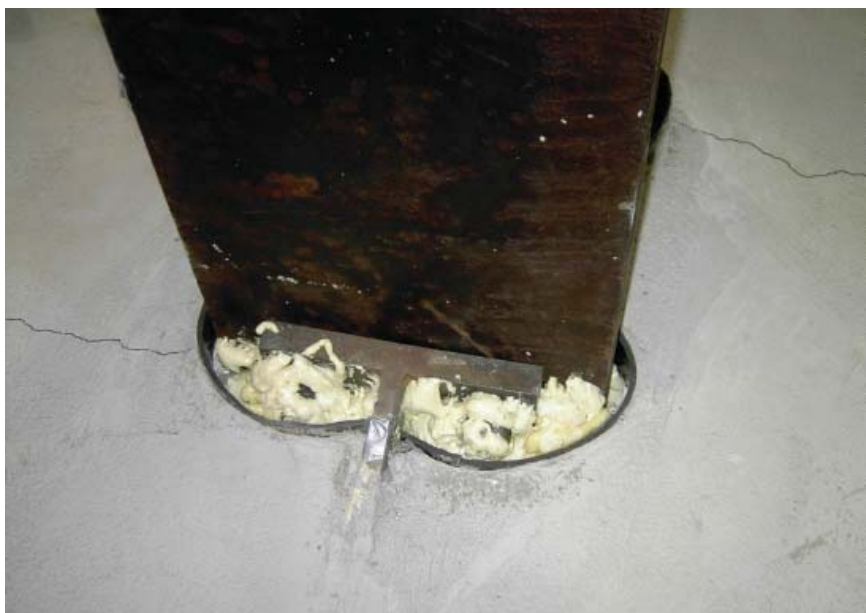
(الف) استفاده از مصالح تراکم‌پذیر بین دال و ستون در اتصال ورق انتهایی
